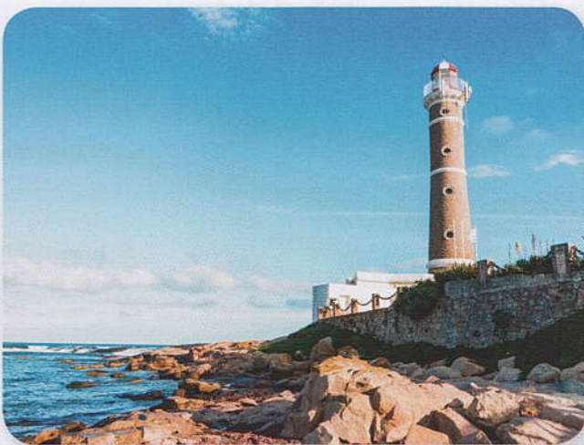
L'érosion d'une falaise exposée aux mouvements des vagues de la mer.
