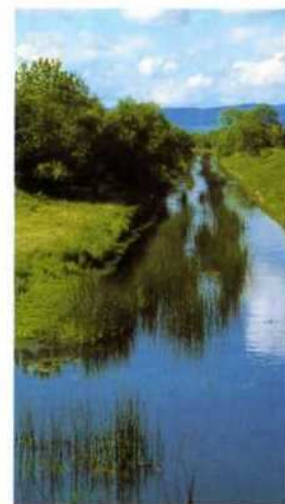
Le cours rectiligne du Drugeon après les travaux de redressement à la pelleuse.
